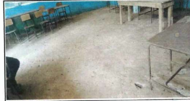
Foto 4: colocacion de pintura en su interior y exterior.
