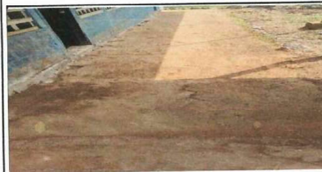
Foto 3: Sustrucion de piso de concreto.
