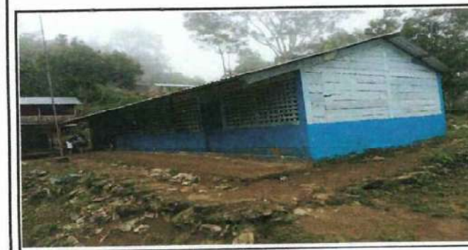
Foto 5: Reabilitacion de estructura de pared.
