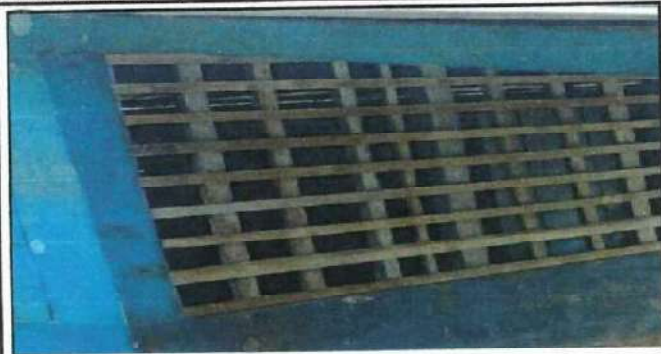
Foto 1: Sustrucion de ventanas de madera a metal con vidrio del modulo 01.
